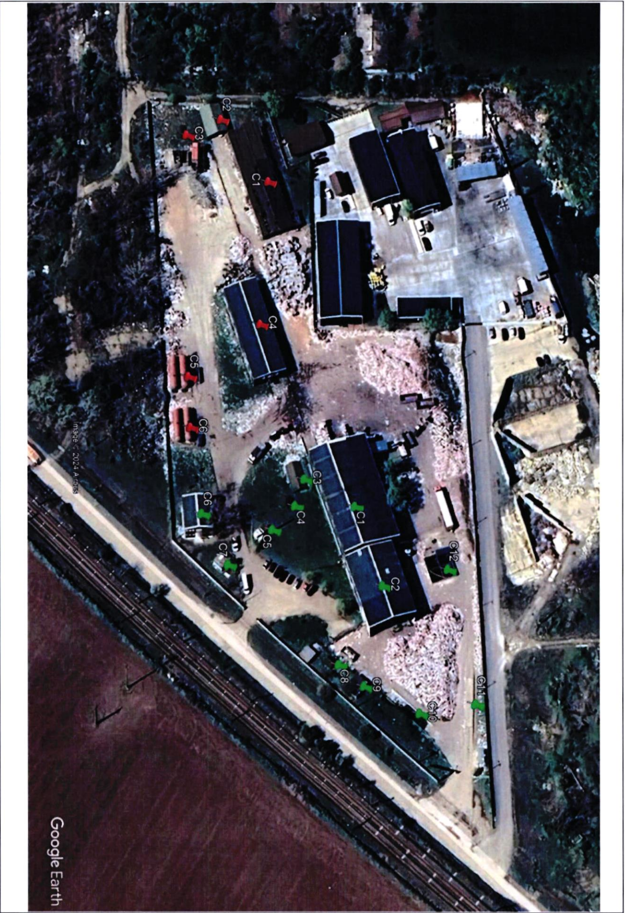
Raport evaluare - clădiri stație sortare deșeurii Arad
